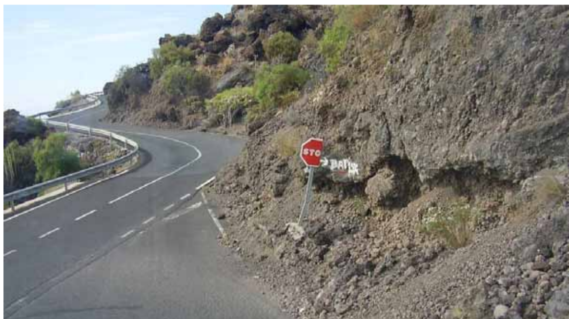
Foto de Diego González Díaz. Vemos el lamentable estado de la señalización bajando de Guía de Isora hacia Playa San Juan.
